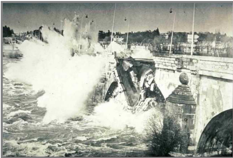
Effondrement du pont Wilson à Tours les 9 et 10 avril 1978
