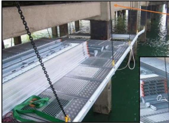
Chaines fixées au béton par goujons d'ancrages et plaquettes
