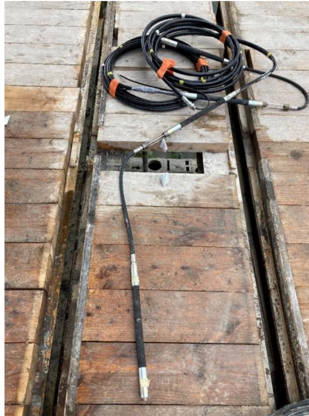
Exemple d'obturateur double utilisé sur le chantier lors du traitement Lors de l'injection d'une passe, 3 manchettes sont prises en simultanée
