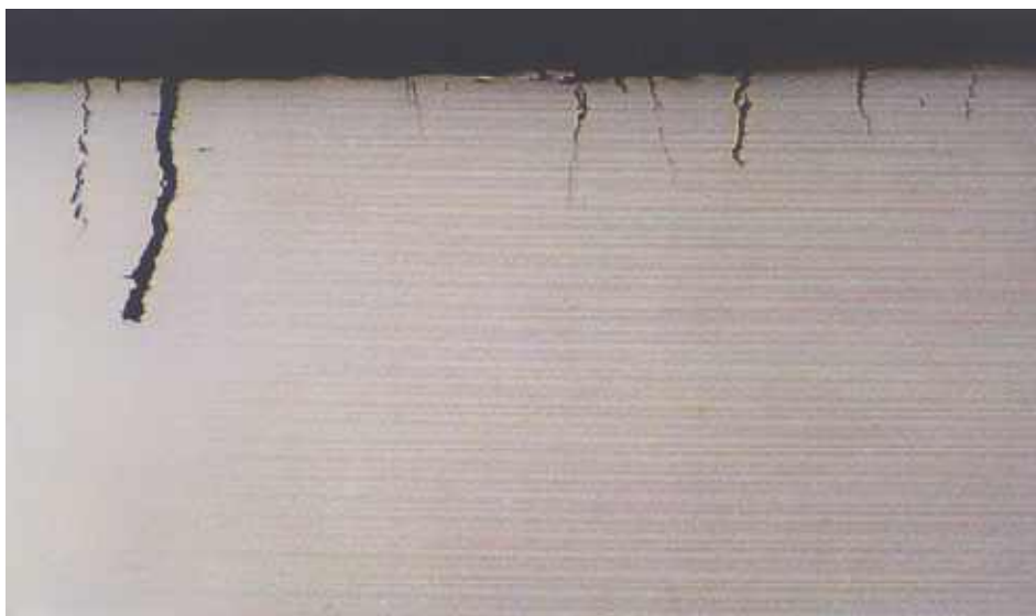
Photo n° 37 : fissures de corrosion fissurante sous tension sur un fil d'un toron (crédit photo LRPC du Bourget)
