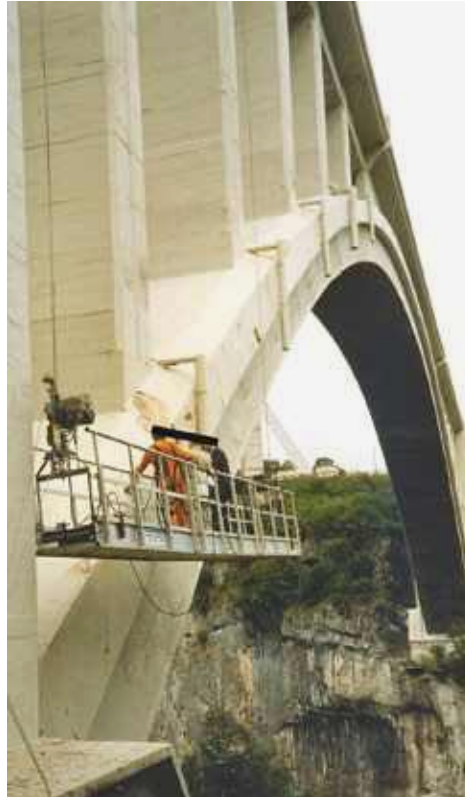
Photo n° 32 : inspection détaillée du pont de la Caille 74 (crédit photo D. Poineau)
