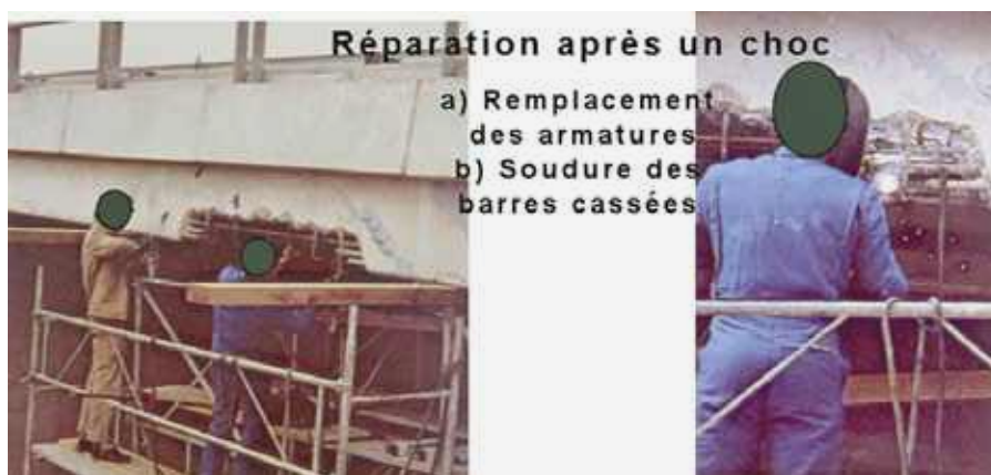
Photo n° 163 : exemple de soudures de barres de béton armé (crédit photo SIKA)
