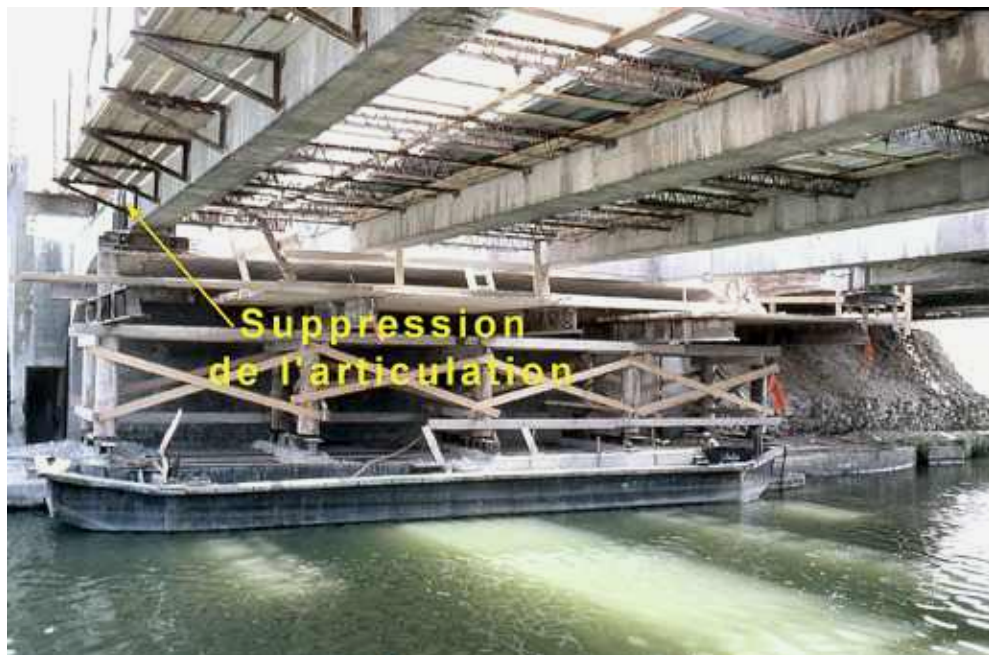
Photo n° 58 : le tablier sur cintre partiel après démolition du hourdis (crédit photo D. Poineau)
