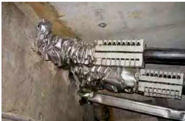
Photo n° 110 : amortisseurs élasto-plastiques (crédit photo Freyssinet)
