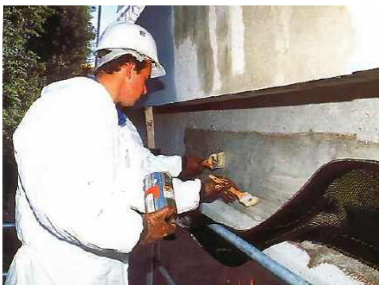
Photo n° 129 : encollage avant pose de tissus en composites (crédit photo Freyssinet)
