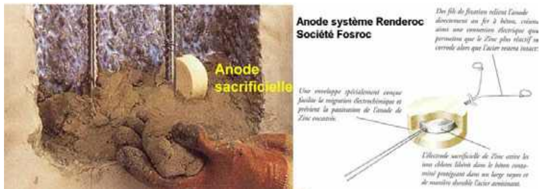
Photo n° 104 : protection galvanique (crédit photo Fosroc)
