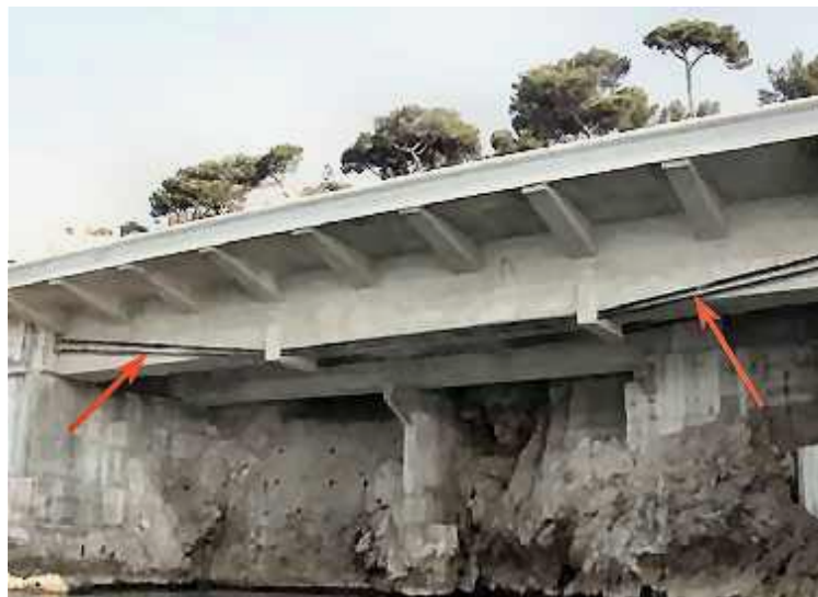
Photo n° 124 : renforcement par précontrainte additionnelle d'un ouvrage de la corniche à Marseille (crédit photo Communauté Urbaine de Marseille)
