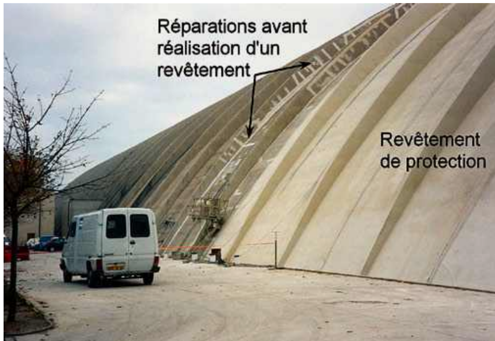
Photo n° 72 : revêtement de protection et d'étanchéité après réparations locales (crédit photo Parexlanko)
