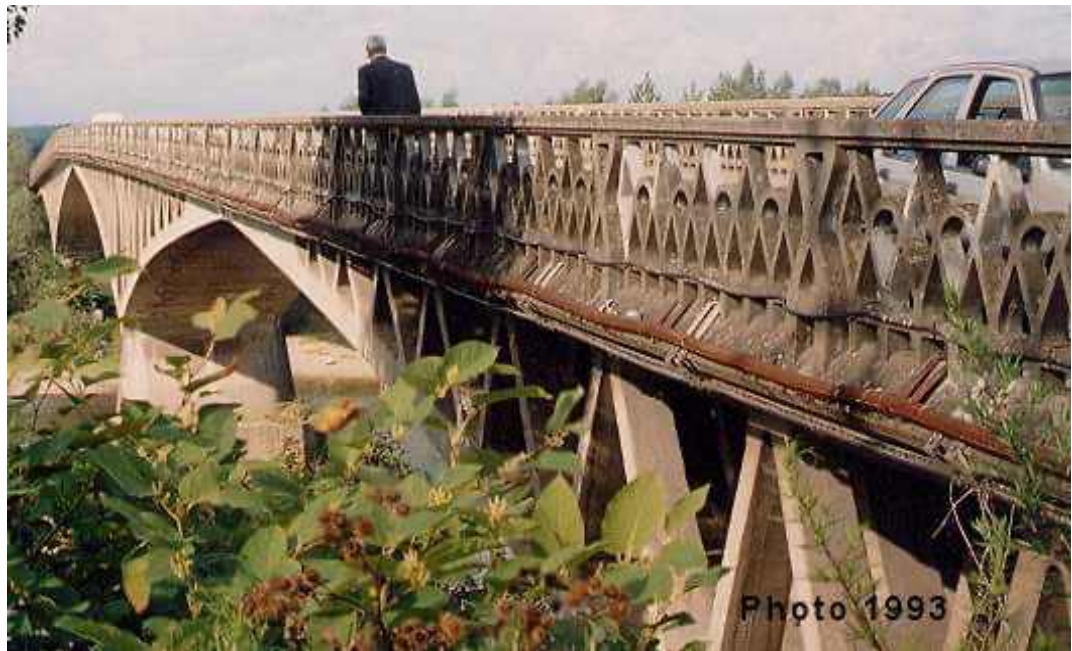
Photo n° 7 : pont de Boutiron dans l'Allier construit vers 1912 par Freyssinet (crédit photo D. Poineau)
