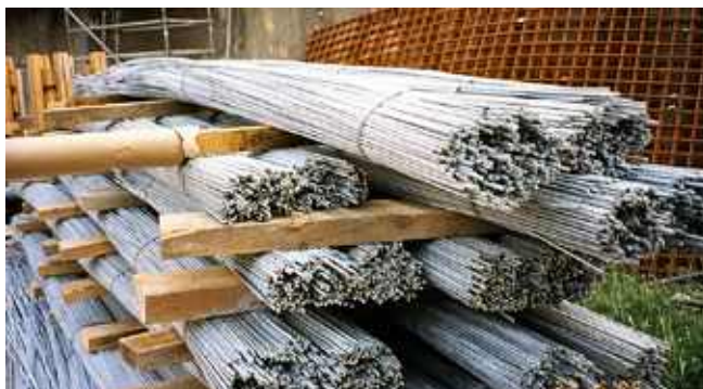
Photo n° 133 : aciers de béton armé galvanisés au Grand Rocher du Zoo de Vincennes (crédit photo D. Poineau)
