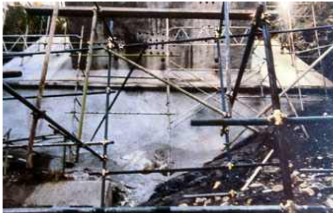
Photo n° 84 : travaux en cours sur un des deux massifs de fondation du pont de la Caille (crédit photo DDE 74)
