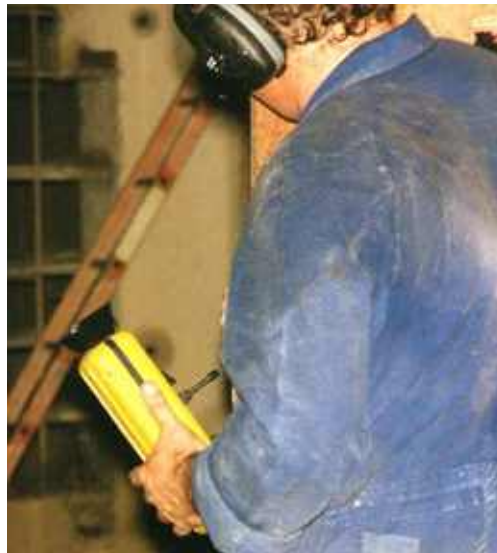
Photo n° 8 : opérateur avec protection phonique (crédit photo J.M. Lacombe)
