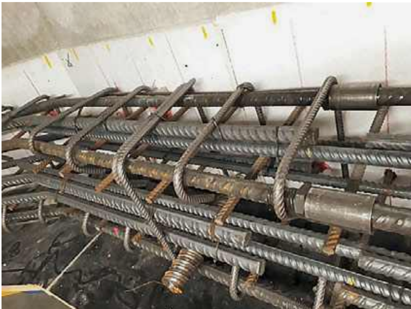
Photo n° 75 : détail du ferrailage d'une nervure – à noter le coupleur limitant le nombre des recouvrements (crédit photo du Département de la Seine Maritime)
