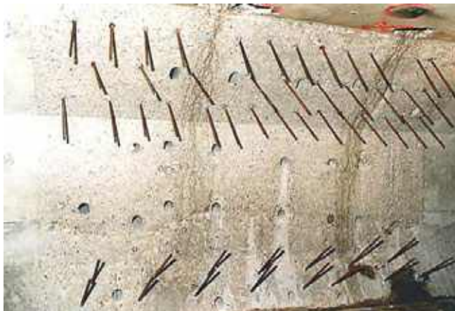
Photo n° 166 : barres scellées au pont de Châlons-en-Champagne (crédit photo D. Poineau)
