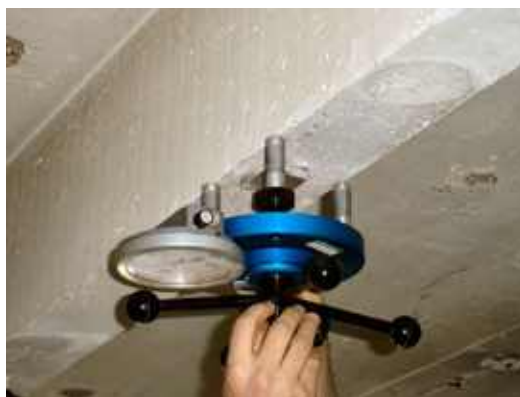
Photo n° 168 : essai de traction de surface pour la mesure de la cohésion du béton (crédit photo VSL)
