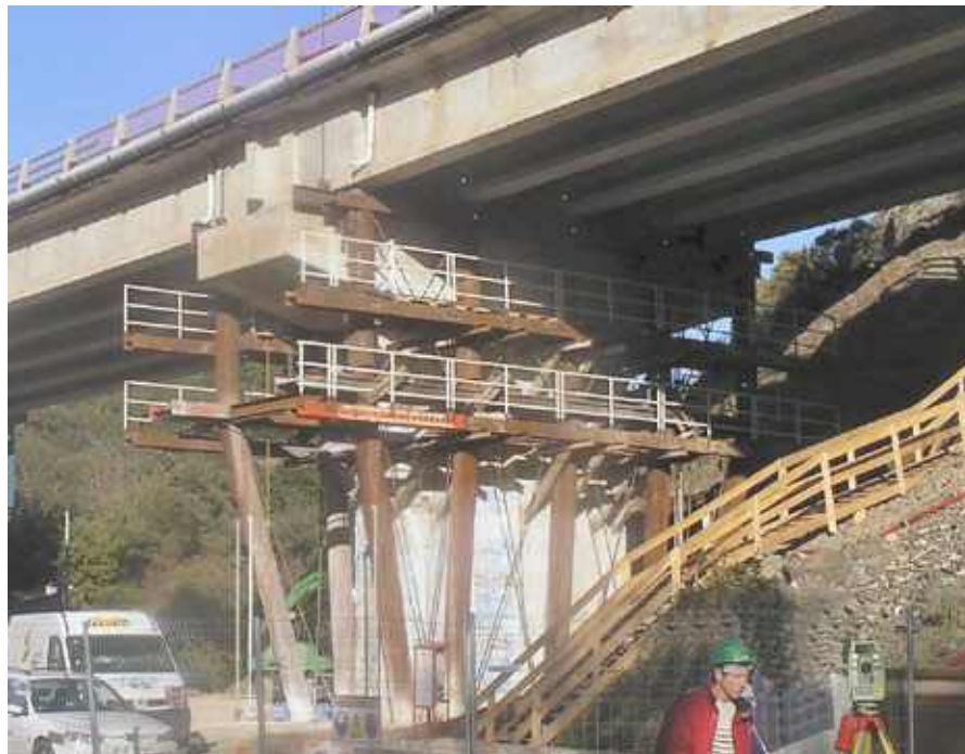
Photo n° 90 : étaieage des deux travées reposant sur le chevêtre (crédit photo CÉTÉ d'Aix-en-Provence - M. Broquet)
