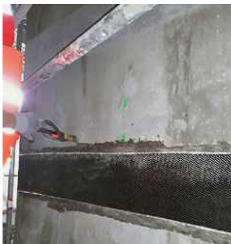
Photo n° 77 : renfort en tissu de fibres de carbone (crédit photo du Département de la Seine Maritime)
