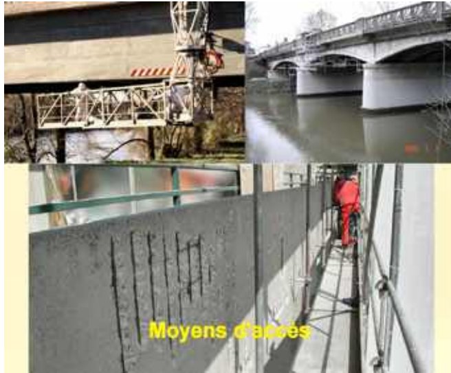
Photo n° 125 : moyens d'accès nécessaires pour l'exécution des travaux (crédit photo Parexlanko)
