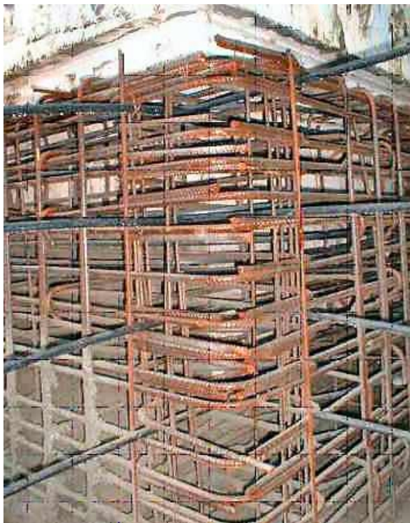
Photo n° 89 : détail du ceinturage (crédit photo Freyssinet)
