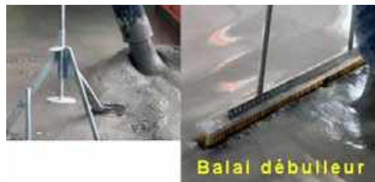
Photo n° 165 : mise en œuvre d'un mortier auto-nivelant (crédit photo SIKA)
