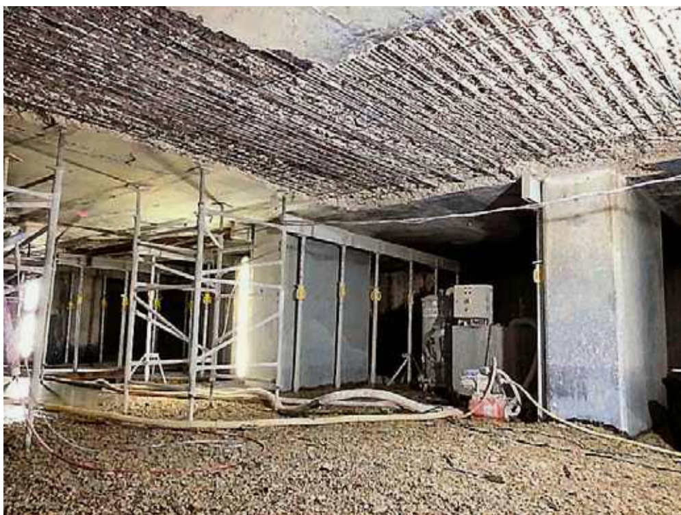
Photo n° 67 : purge terminée (crédit photo Freyssinet)
