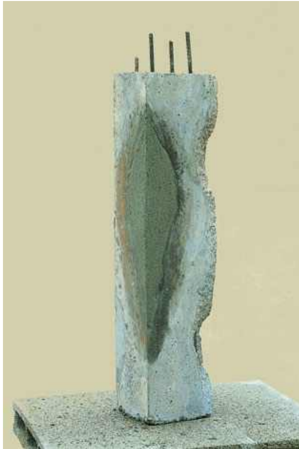
Photo n° 97 réparation par enlèvement du béton pollué terminée (crédit photo Parexlanko)
