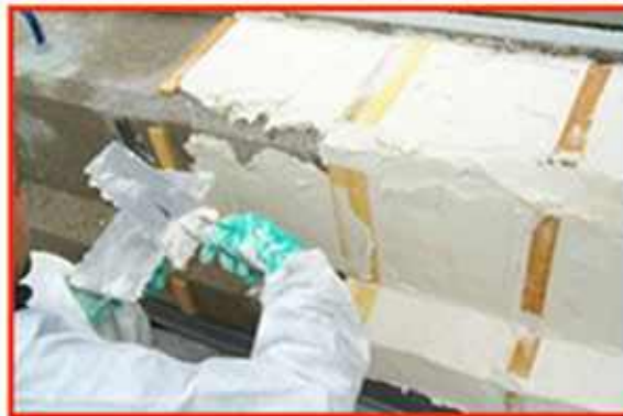
Photo n° 100 : extraction et réalcalinisation par anode active phase 1 (crédit photo Ifsttar / Freyssinet)
