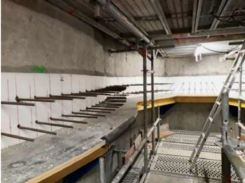
Photo n° 74 : début de mise en place des coffrages d'une nervure et scellement d'armatures de BA dans les parois (crédit photo du Département de la Seine Maritime)
