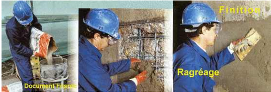
Photo n° 144 : exécution d'une réparation de surface manuellement (crédit photo Fosroc)
