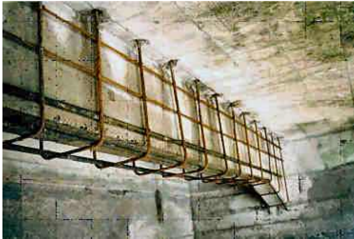
Photo n° 116 : renforcement des poutres de la passerelle du barrage de Pizançon (crédit photo Freyssinet)
