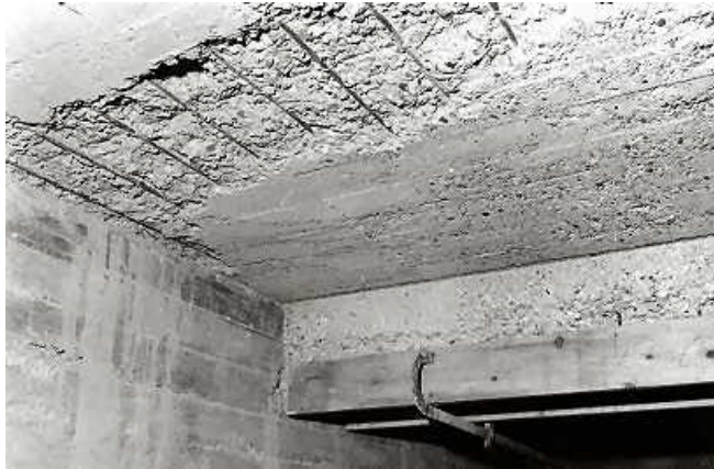
Photo n° 153 : résultat d'un décapage par sablage à sec (crédit photo D. Poineau)
