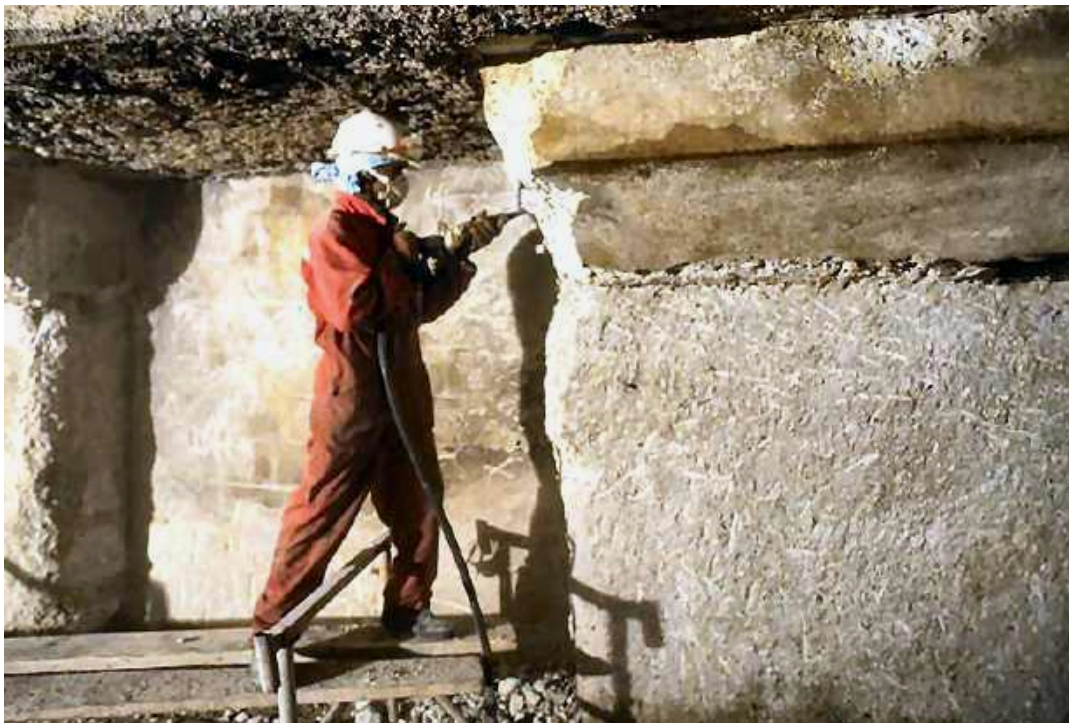
Photo n° 65 : repiquage du béton endommagé au marteau-piqueur (crédit photo Freyssinet)
