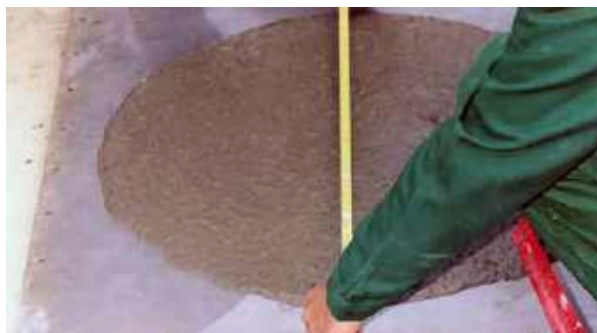
Photo n° 172 : contrôle d'étalement d'un BAP (crédit photo LRPC Clermont - M. Geoffrey)
