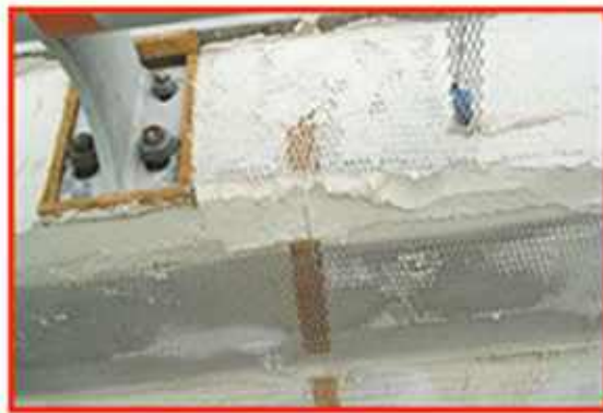
Pose de l'anode en aluminium Système d'humidification Boîtiers de contrôles
