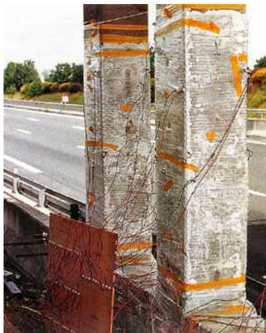
Photo n° 138 : opération de déchloruration (crédit photo Direction des Routes)
