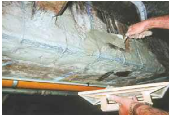
Photo n° 164 : mise en place de mortier de réparation à la truelle (crédit photo Parexlanko)
