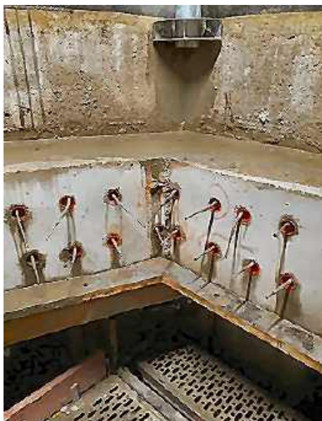
Photo n° 76 : armatures de jonction entre les parois de la pile et la nervure scellées dans des réservations de la nervure (crédit photo du Département de la Seine Maritime)
