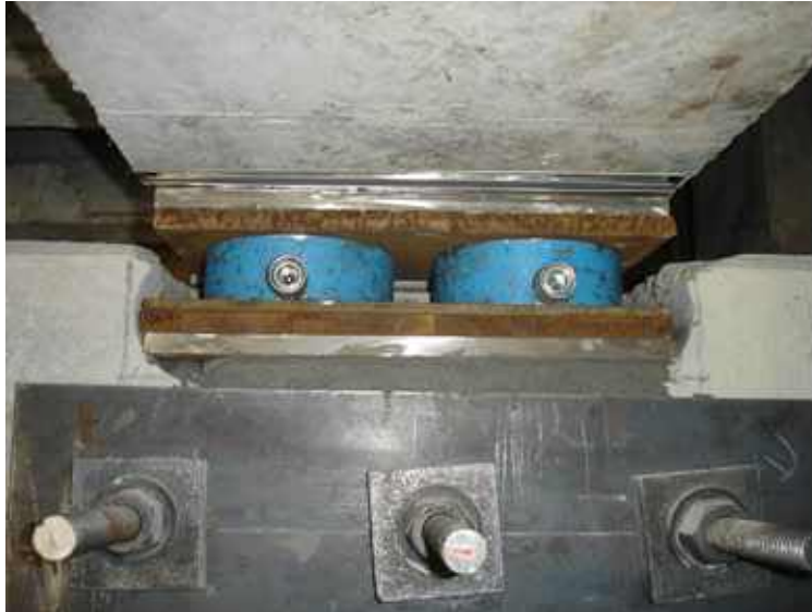
Photo n° 4 : adaptation du matériel de vérinage aux emplacements disponibles et renforcements pour équilibrer les efforts concentrés (crédit photo VSL - M. Loubeyre)
