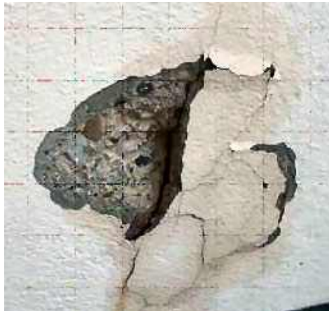
Photo n° 94 : corrosion par inversion de polarité après réparation (crédit photo Freyssinet)
