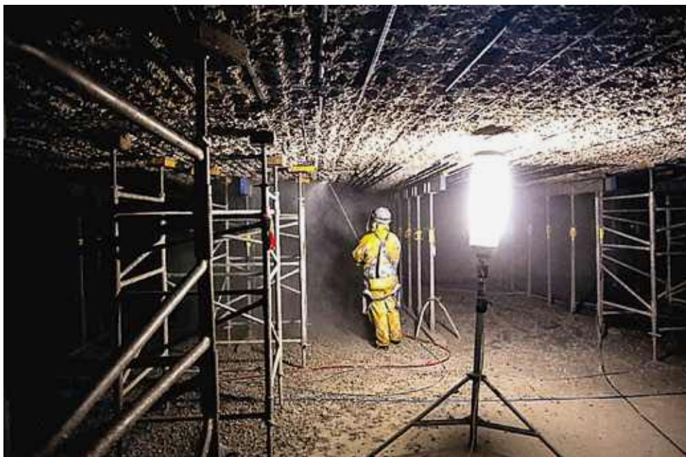
Photo n° 66 : purge du béton endommagé en cours (crédit photos Freyssinet)
