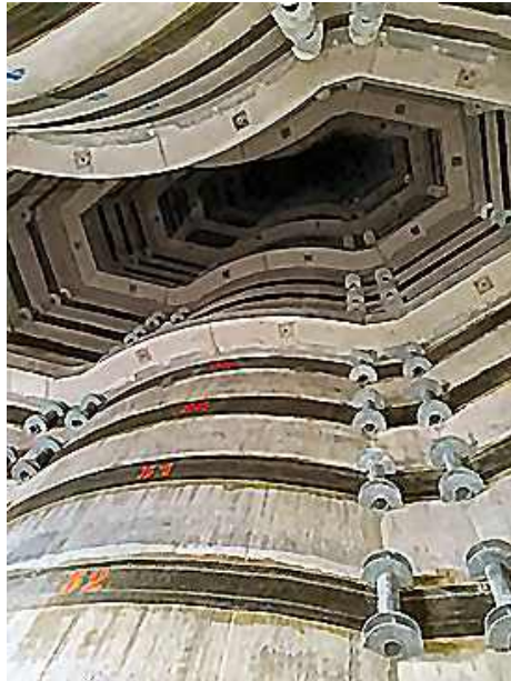
Photo n° 78 : vue des nervures et des renforts en tissu de fibres de carbone collés équipés de dispositifs anti poussée au vide (crédit photo du Département de la Seine Maritime)
