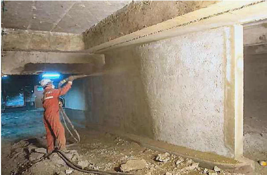
Photo n° 68 : projection de béton sur une paroi verticale (crédit photo Freyssinet)
