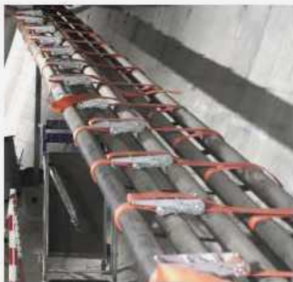
Dispositifs de guidage par sangles et portiques métalliques
