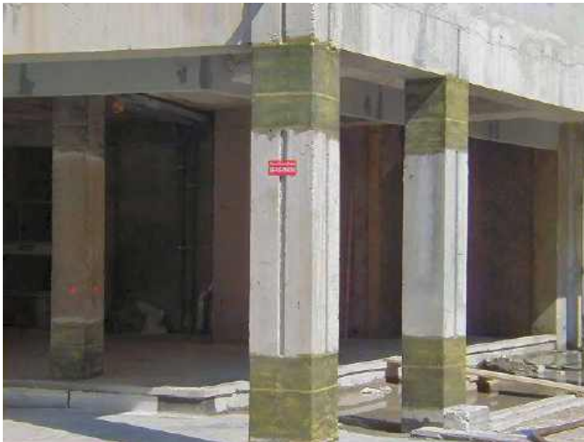
Photo n° 122 : frettage de poteaux par composites (crédit photo Freyssinet)
