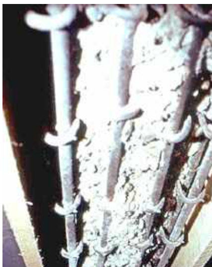
Photo n° 147 : planches matérialisant le coffrage d'une poutre (crédit photo D. Poineau)
