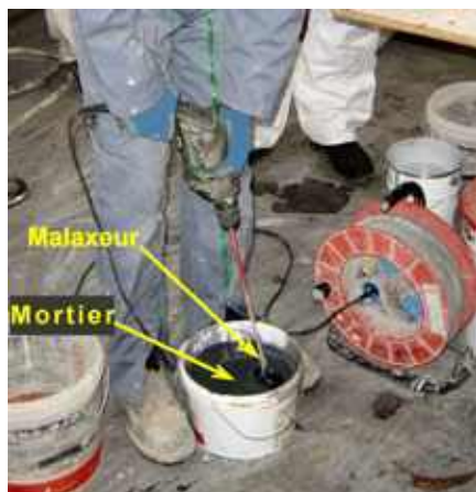
Photo n° 142 : préparation d'un mortier de réparation à base de liants hydrauliques (crédit photo Parexlanko)
