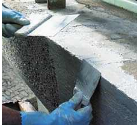
Photo n° 55 : application d'un revêtement de protection sur la corniche d'un pont (crédit photo LCPC)
