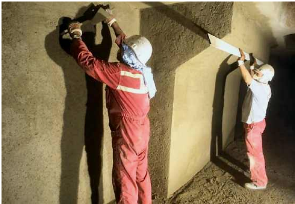
Photo n° 70 : travaux de finition des parements à la règle (crédit photo Freyssinet)
