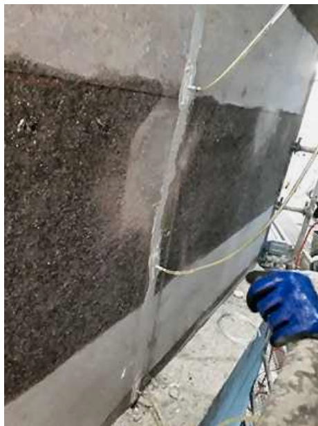
Photo n° 79 : injection des fissures (crédit photo du Département de la Seine Maritime)
