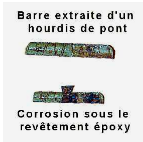
Photo n° 92 : corrosion d'une armature de béton armé revêtue d'époxy (extrait d'une revue US)
