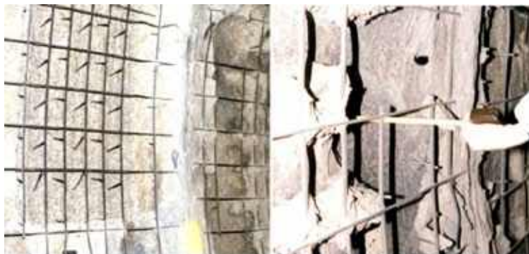
Photo n° 9 : béton après un incendie (crédit photo CETU)
