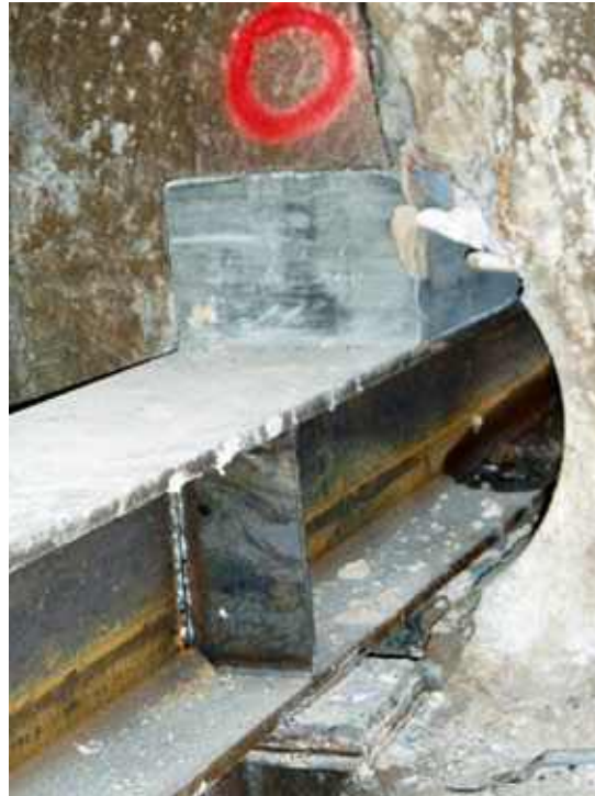
Photo n° 130 : réalisation d'un calage pour une reprise en sous-œuvre (crédit photo Parexlanko)
