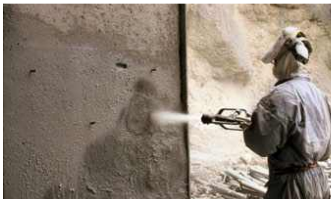
Photo n° 146 : projection en cours (crédit photo Parexlanko)
