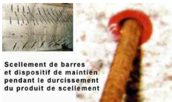
Photo n° 150 : scellement d'armatures de béton armé (crédit photo D. Poineau)
