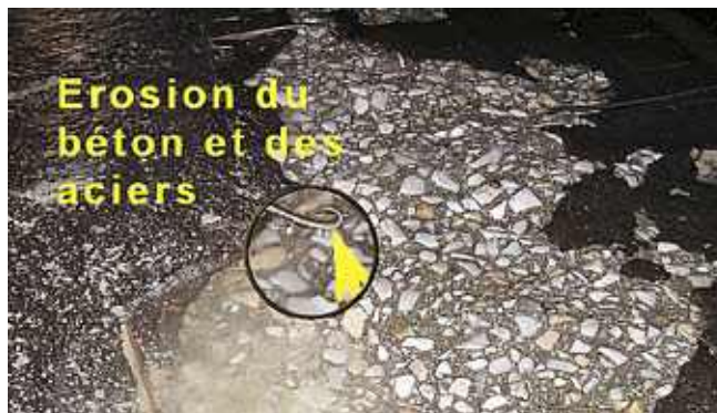
Photo n° 81 : érosion hydraulique du radier de la chute des Bois près de Chamonix (crédit photo Weargrit)
