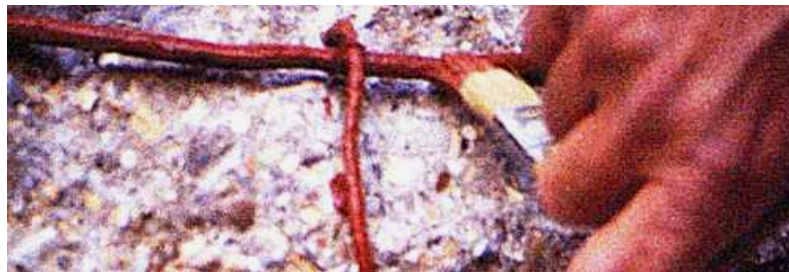
Photo n° 99 : application d'un revêtement anticorrosion sur des armatures de BA (crédit photo Weber et Broutin)
