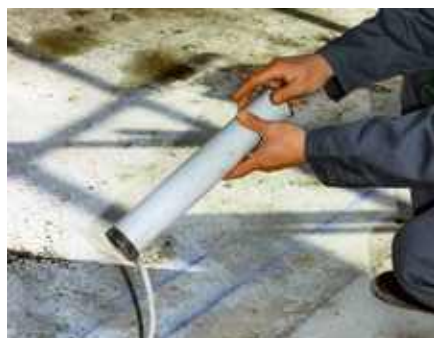
Photo n° 149 : remplissage des trous avant scellement de barres (crédit photo Parexlanko)
