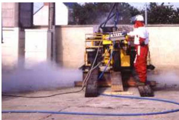
Photo n° 5 : robot Conjet en démonstration (crédit photo D. Poineau)
