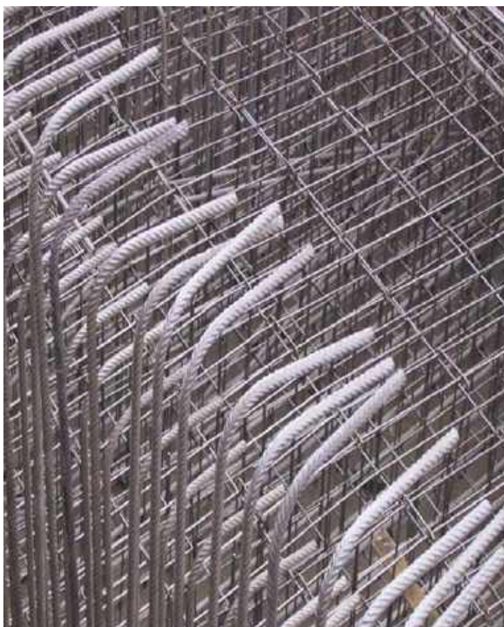
Photo n° 1 : armatures de béton armé en acier inoxydable (crédit photo F. Moulinier)
