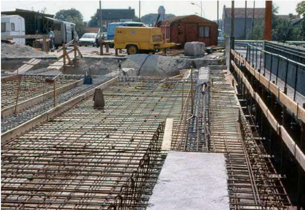
Photo n° 59 : le tablier après reconstitution du ferrailage du hourdis et avant bétonnage (crédit photo D. Poineau)
