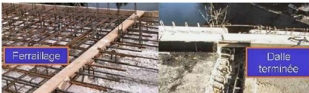
Photo n° 117 : renforcement du hourdis supérieur du pont de Guignicourt par béton contrecollé (crédit photo D. Poineau)
