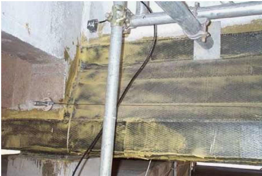
Photo n° 115 : renforcement en tissu composite des abouts des poutres du pont sur la Drôme (crédit photo RCA - M. Trouillet)
