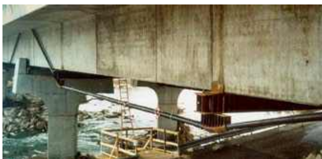
Photo n° 137 : précontrainte provisoire pour le remplacement de la précontrainte extérieure de l'ouvrage de Val Durance (crédit photo D. Poineau)
