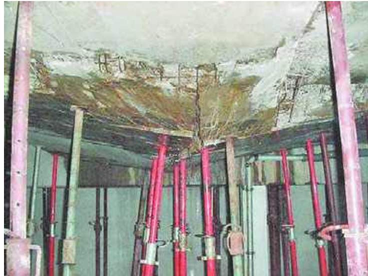
Photo n° 158 : étaie provisoire (crédit photo Parexlanko)
