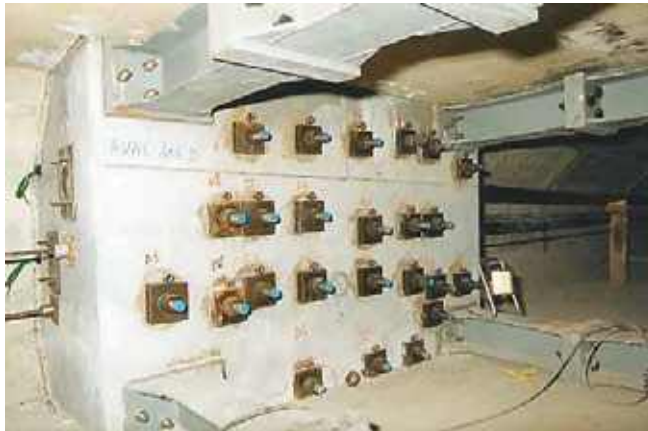
Photo n° 167 : massif d'ancrage de la précontrainte additionnelle longitudinale au pont de Châlons-en-Champagne (crédit photo Sétra)
