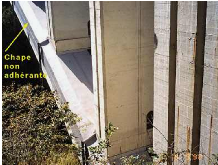
Photo n° 64 : vue de l'arc avec sa chape d'étanchéité non adhérente (crédit photo D. Poineau)
