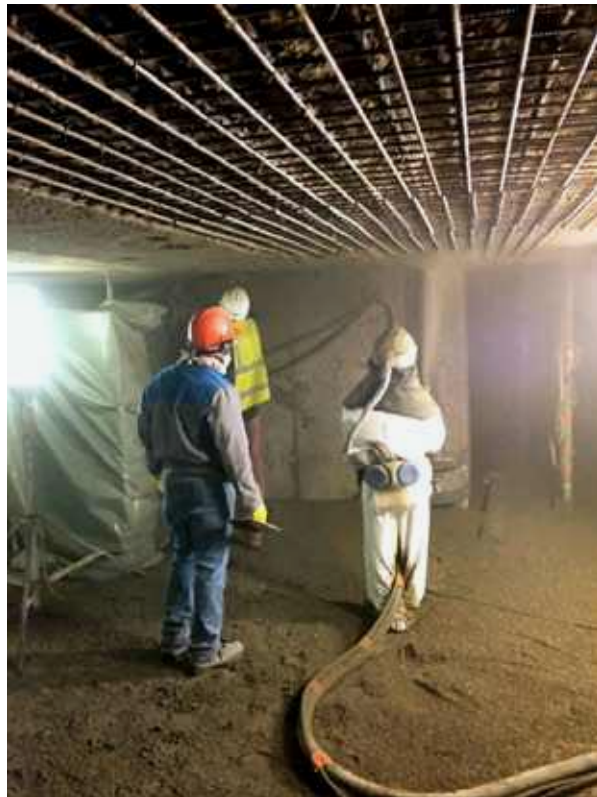
Photo n° 69 : projection de béton en sous-face d'une dalle (crédit photo Freyssinet)
