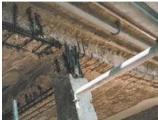
Photo n° 170 : exemple de travaux nécessitant un étaie provisoire (crédit photo Parexlanko)
