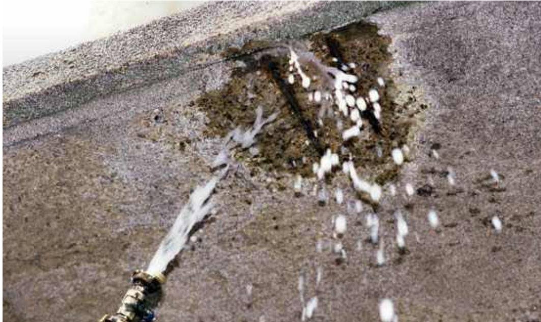
Photo n° 143 : humidification du substratum (crédit photo Parexlanko)
