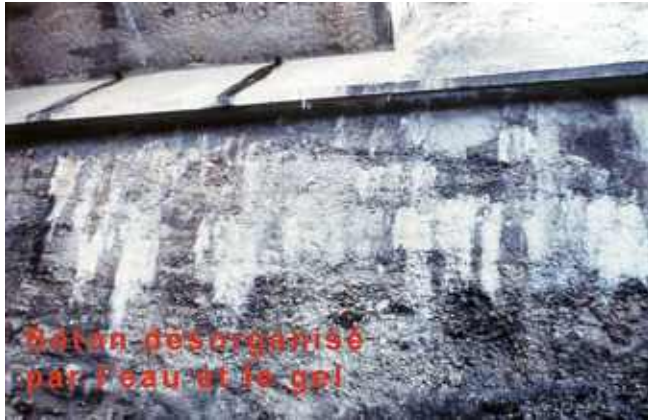
Photo n° 83 : un des deux massifs de fondation du pont de la Caille avant mise en œuvre du béton projeté (crédit photo DDE 74)
