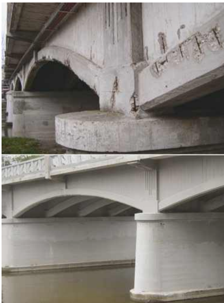
Photo n° 175 : pont avant et après travaux de restauration (crédit photo Parexlanko)
