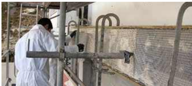
Photo n° 152 : opération d'extraction des chlorures-réalcalinisation sur une poutre d'un immeuble (crédit photo Freyssinet)
