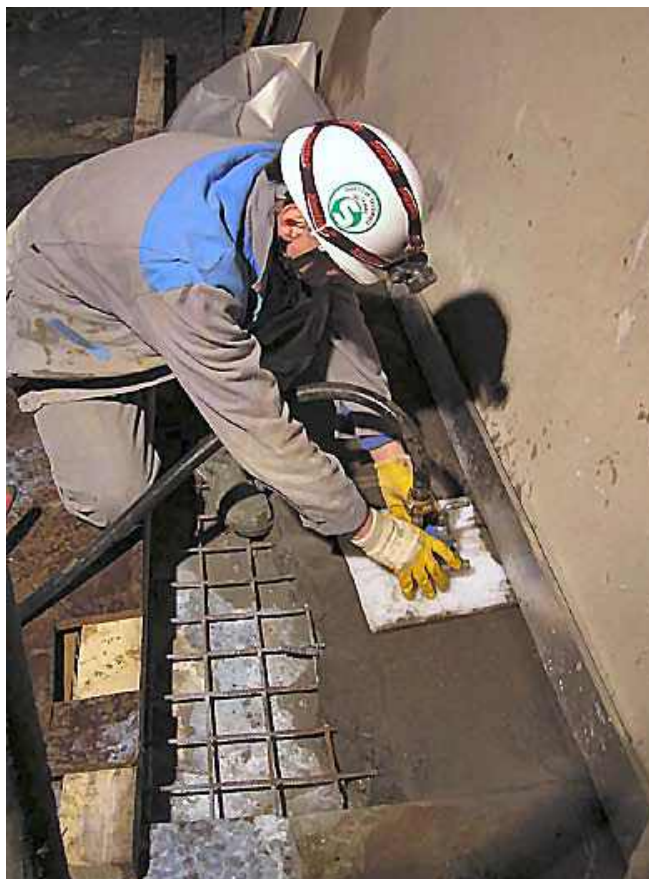
Photo n° 82 : réparation du radier de la chute des Bois près de Chamonix (crédit photo Weargrit)
