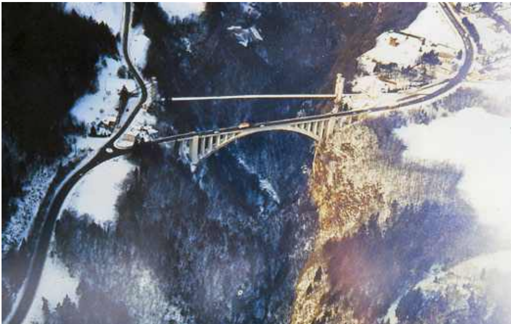
Photo n° 60 : vue générale du pont de la Caille en hiver (crédit photo DDE 74)
