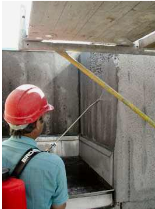
Photo n° 107 : application d'un inhibiteur de corrosion à la surface du béton (crédit photo Parexlanko)
