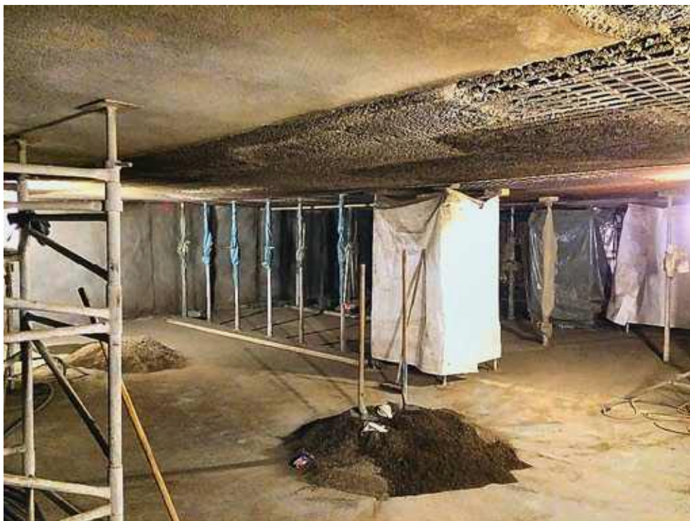
Photo n° 71 : vue de la sous-face d'une dalle reconstituée (crédit photo Freyssinet)
