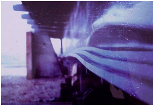
Figure 82 : Voilement d'âme en cours de lancement (photo Jean-Paul PERSY).
