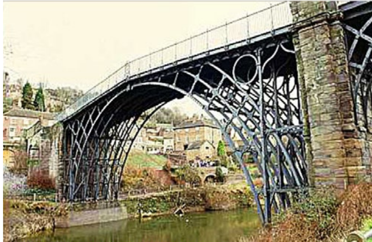
Fig. 7 : Pont de Coalbrookdale sur la Severn (document bibliographique).
