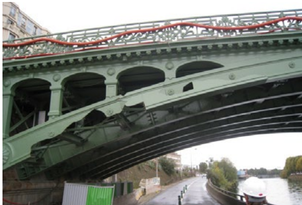
Figure 54 : Choc de véhicule sur un arc en fonte de 1903 (photo Jean-Paul PERSY).
