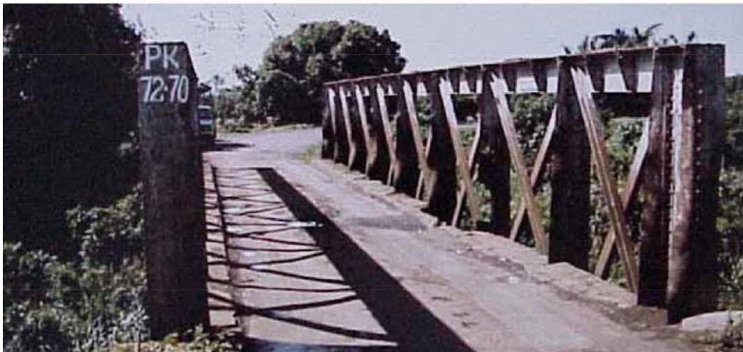
Fig. 122 : Pont Pigeaud - assemblages par boulons ordinaires (photo Jean-Paul PERSY).
