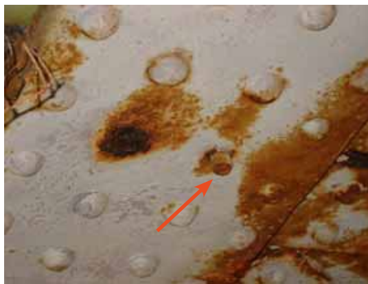
Fig. 140 : Remplacement de rivets par rivelon sur assemblage rivé (photo Jean-Paul PERSY).
