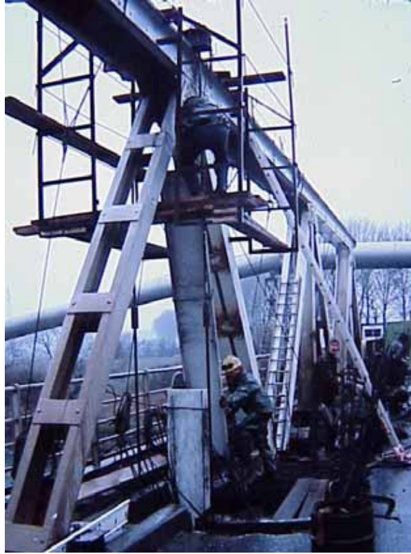
Fig. 88 : Remplacement d'un montant d'une poutre treillis - dispositif provisoire de reprise des efforts par barres de brelage (photo Jean-Paul PERSY).
