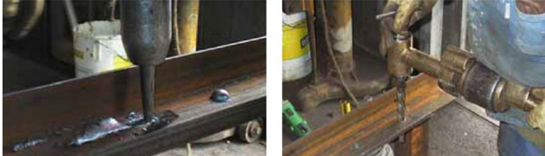
Fig. 151 : Chasse du corps du rivet et alésage du trou au diamètre supérieur (photos Eiffel).
