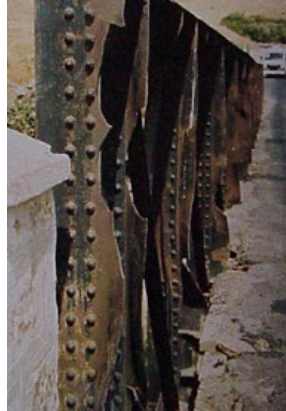
Figure 53 : Ruptures sur acier fragile par chocs de véhicules – acier des années 1925 environ (photo Jean-Paul PERSY).
