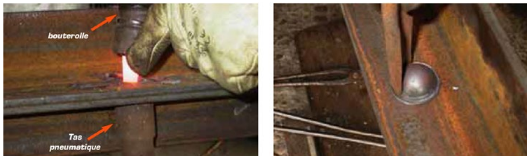
Fig. 152 : Pose d'un rivet à tête ronde et gougeage de la tête de rivet (photos Eiffel).
