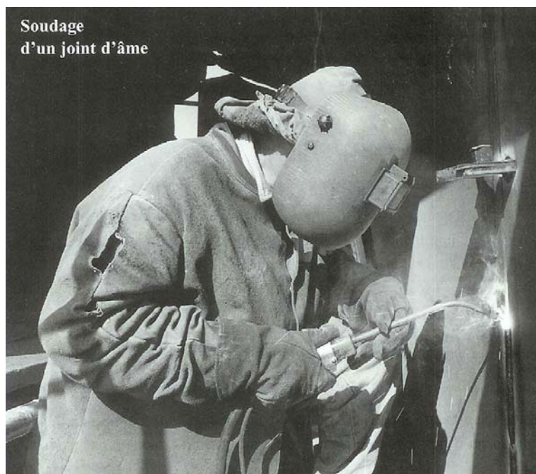
Fig. 115 a et b : Soudage à l'arc avec fil fourré (bibliographie [6]).
