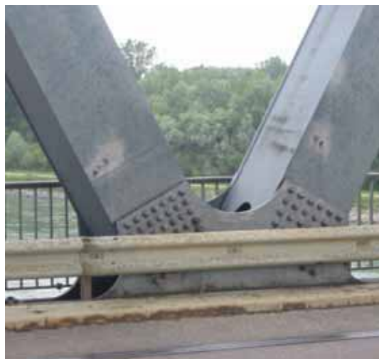
Fig. 123 : Pont Warren sur le Rhin - Construction soudée - assemblages boulons HR (~1965) - (photo Jean-Paul PERSY).
